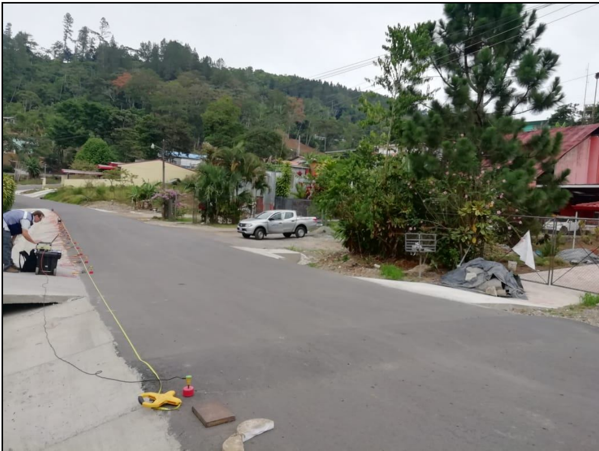
Fotografía 2. Ejecución del ensayo MASW-3.
