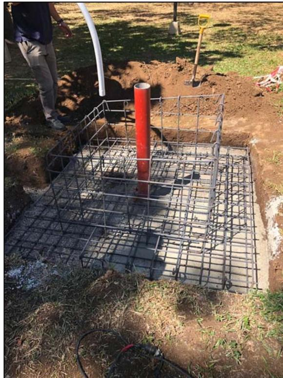
**Fotografía 4: Armadura de la estructura de protección.**
