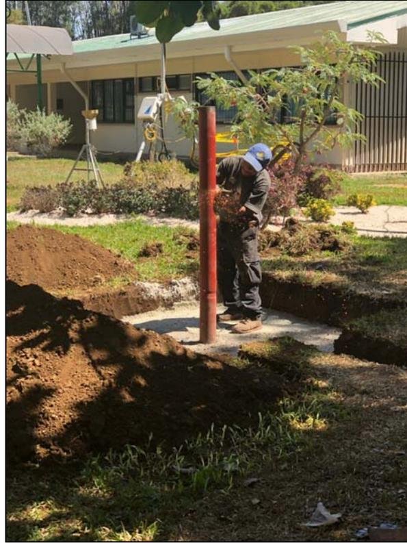
**Fotografía 3: Instalación final de la tubería del pozo.**
