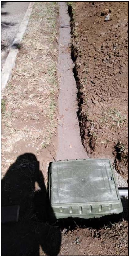
Fotografías 7 y 8: Canal para tubería eléctrica.
