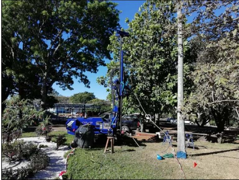
**Fotografía 1: Perforación a rotación para construcción del pozo.**
