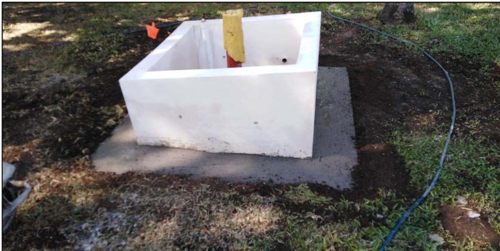
Fotografías 5 y 6: Construcción de estructura de protección de los equipos.
