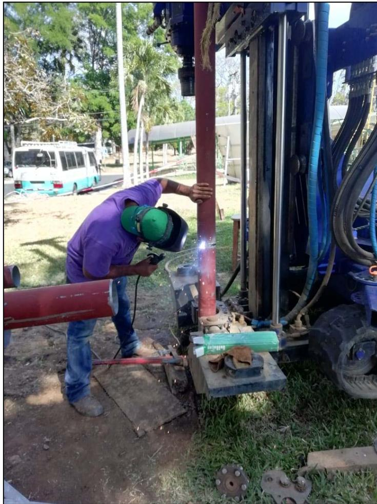
**Fotografía 2: Instalación y soldadura de la tubería.**
